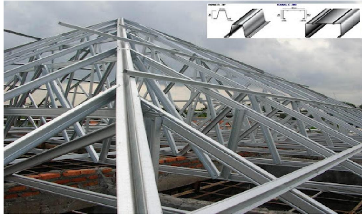
Gambar 1. Rangka Atap Baja Ringan Sumber : Dokumentasi Pribadi
